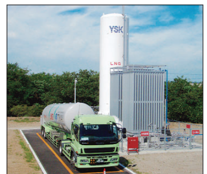
大東工場に設置された天然ガスの貯蔵基地
