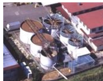
▲榛原工場の排水処理施設
