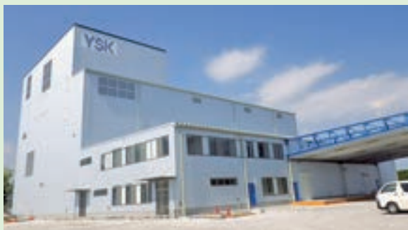
建設中の新工場外観（平成26年5月現在）
