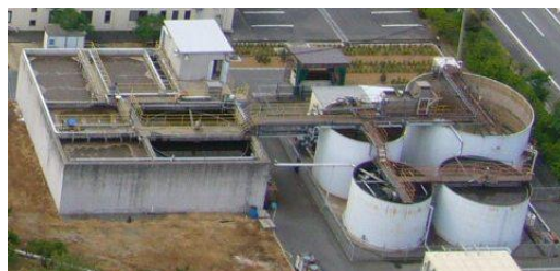
▲大東工場の排水処理施設
