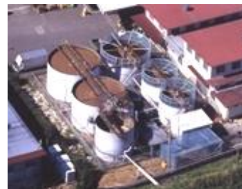
▲榛原工場の排水処理施設
