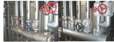
▲蒸気配管の保温材施工前（左）と後（右）
