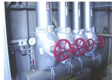
▲蒸気配管の保温施工
